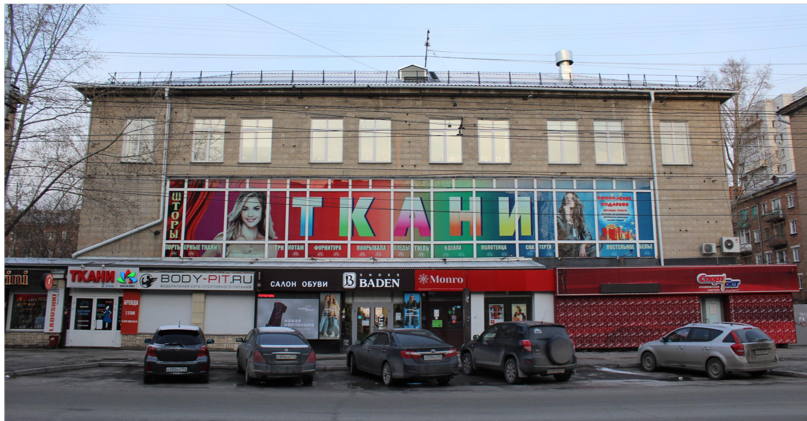
Главный фасад 1-7, выходящий на проспект Карла Маркса
